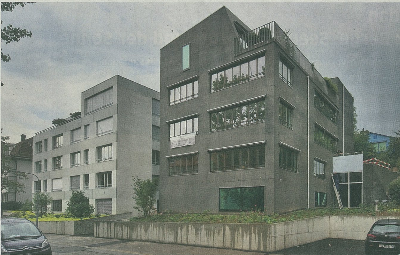
Effizienz und Erfindergeist prägen diesen Prototyp CO 2 -freien Wohnens an der Bolleystrasse in Zürich.
